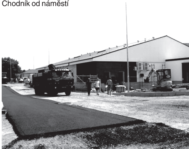
První asfaltový koberec
