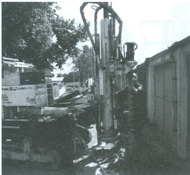
Aplikace mikročástic železa do kontejneru podzemních vod
