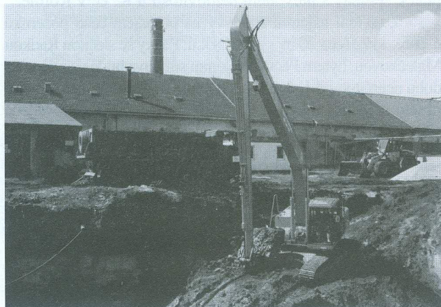
Odtěžba a odvoz kontaminovaných zemin
