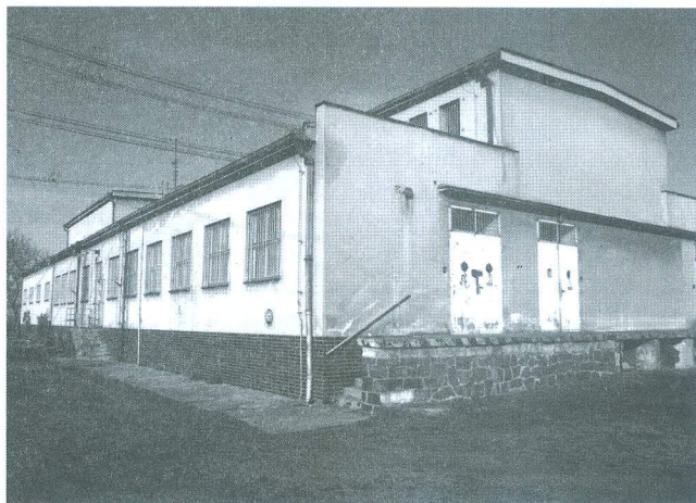
Hlavní provozní budova trakční měnárny Pečky
