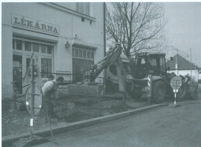
Zhotovení posledního úseku
