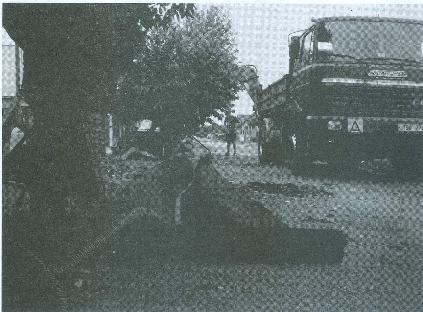
Práce na opravě krytu komunikace Prokopa Holého budou probíhat do konce září 2013, stavbu provádí firma Halko stavební společnost, s. r. o. Nová Ves.
