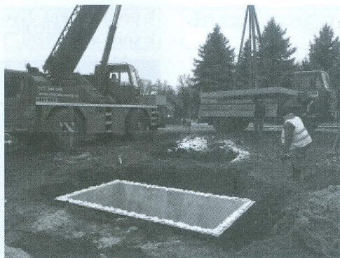
Usazení napojovacího objektu v Radimi
